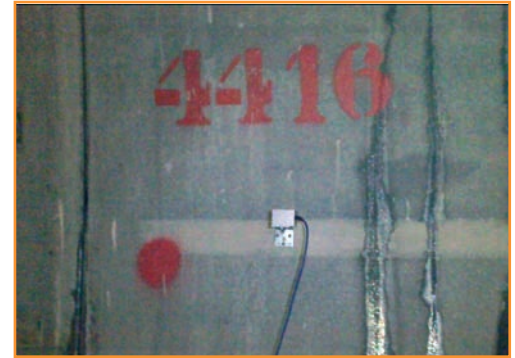
[Figura 3].- Ubicación del captador en la dovela.
